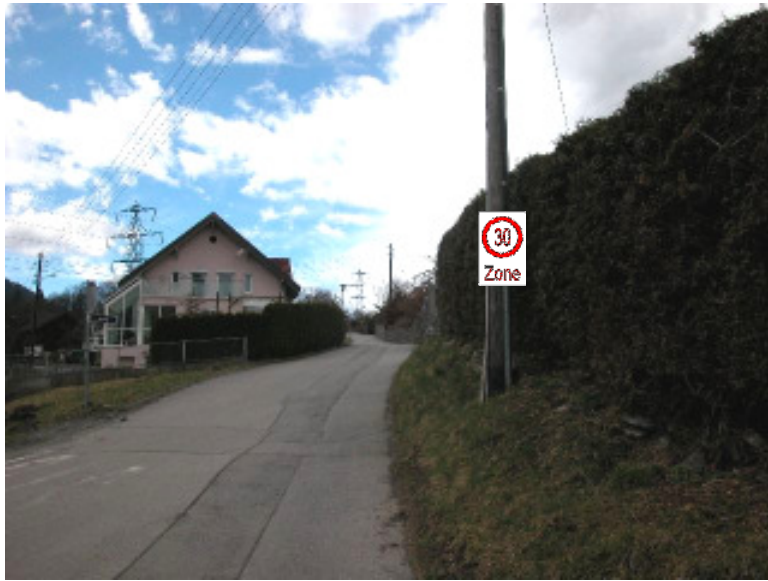
Abbildung 8: Zonenbeschränkung 30 im Luzebild, Höhe Einmündung Bazulstraße
